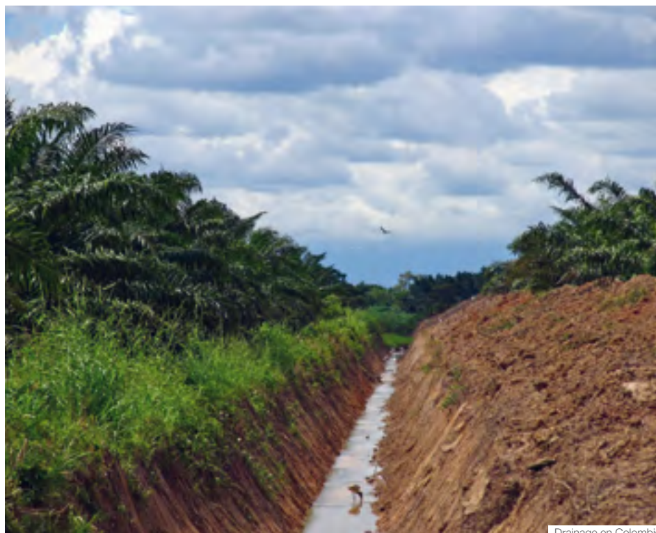
Drainage en Colombie
